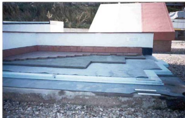
CUBIERTA INVERTIDA TRANSITABLE SOLADO FIJO: BALDOSIN CATALÁN
