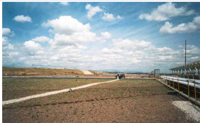
CUBIERTA ECOLOGICA. BARAJAS PARKING T4
